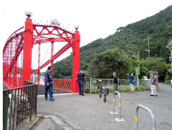
【南河内橋の見学】
