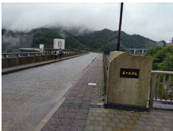
【ダム天端の様子】
