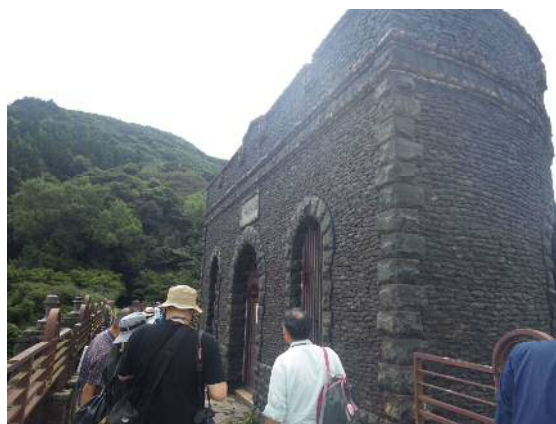
【取水塔の様子】
